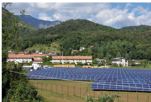
Fig. 12 – panoramica dell'impianto fotovoltaico esistente a nord della SR 464 (zona D.6 del PRGC)
