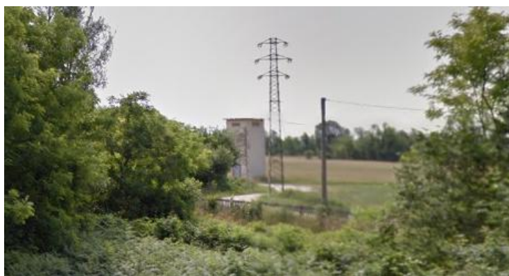
Fig. 11 – particolare della cabina esistente sulla via Clauzetto
